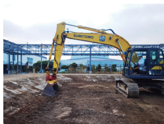
Corte de Taludes
