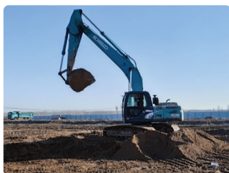
Nivelación del Terreno
